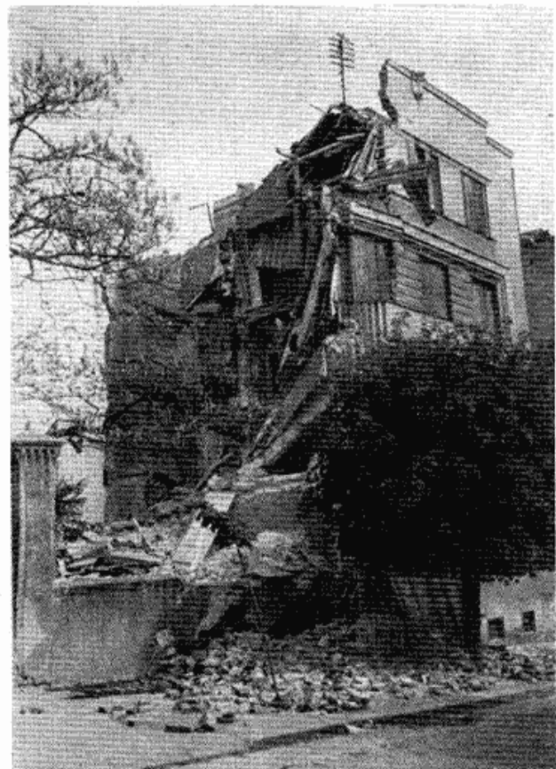
Сл. 2 — Изглед порушене зграде у улици Краља Милутина после бомбардовања 6 априла 1941 године. Фотографија Музеја града Београда
