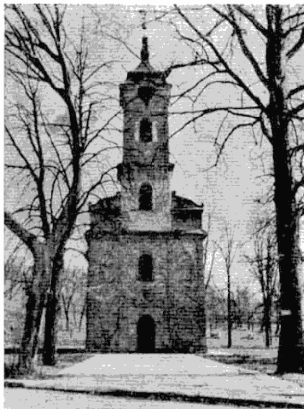
Сл. 4 — Кнез Милошева црква у Топчидеру, изглед са запада
