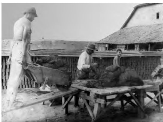
Слика 2. Циглана Јована С. Марковића и Боже Брковића: тезге на којима је земља ручно мешана и обликована цигла у „рилкама“ Fig. 2 Brickyard of Jovan S. Marković and Boža Brković: benches for kneading the clay and brick moulds
