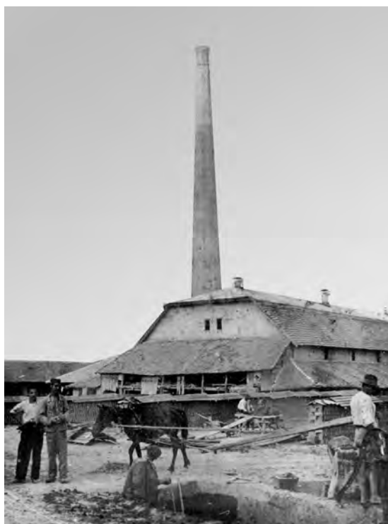
Слика 1. Циглана Јована С. Марковића и Боже Брковића: мешање земље и воде уз помоћ коња Fig. 1 Brickyard of Jovan S. Marković and Boža Brković: clay and water mixing using a horse
