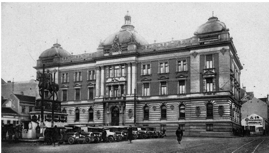
Слика 2. Палата Управе фондова, фронт Fig. 2 Mortgage Bank ( Uprava fondova ) building, front
