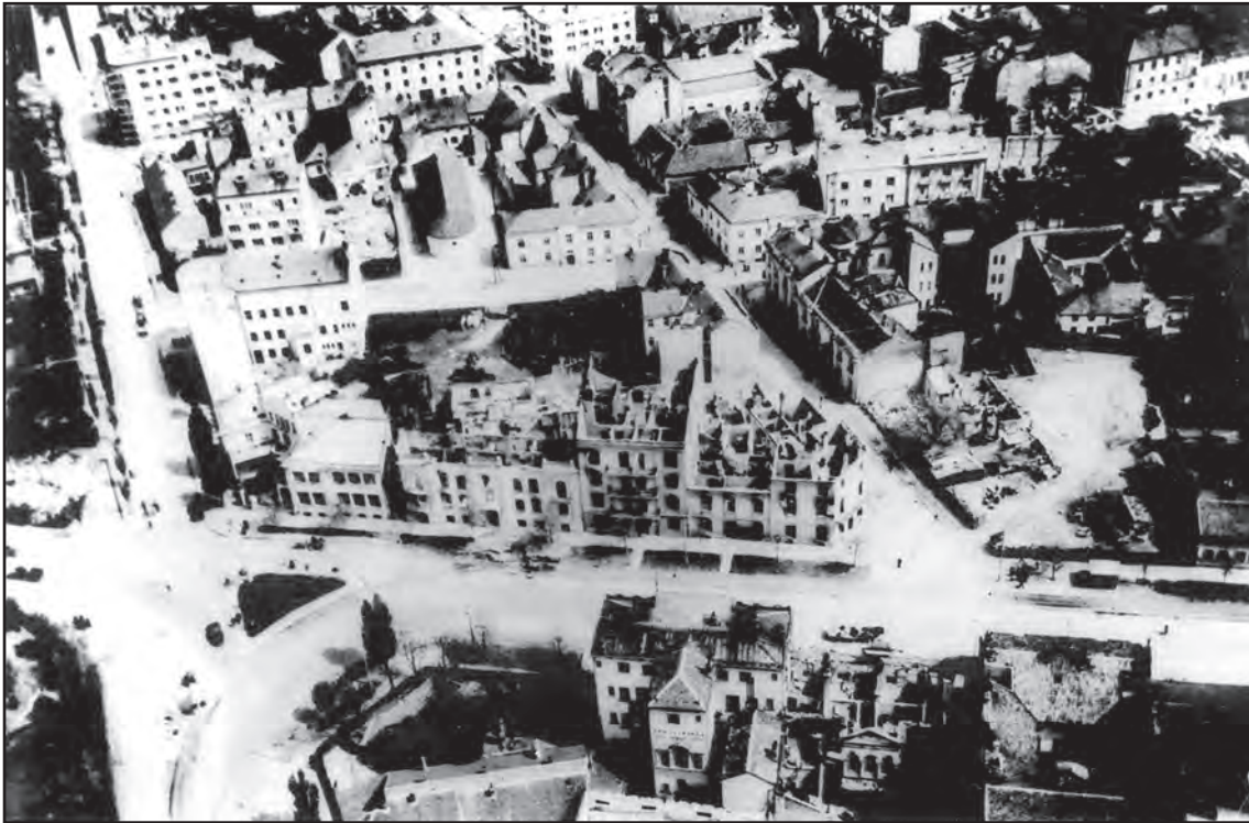
Сл. 2. Порушени објекти у кварту омеђеном улицама Цара Душана, Маршала Пилсудског (Тадеуша Кошћушка), Високог Стевана и Јеврејском. У првом плану је зграда Старе синагоге (кат. бр. 19)
