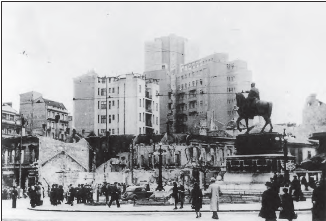
Сл. 4. Изглед Позоришног трга (Трг републике) после бомбардовања 6. априла 1941 (кат. бр. 22) Fig. 4 Theatre Square (Trg republike) after the bombing of April 6, 1941 – Cat. no 22 –
