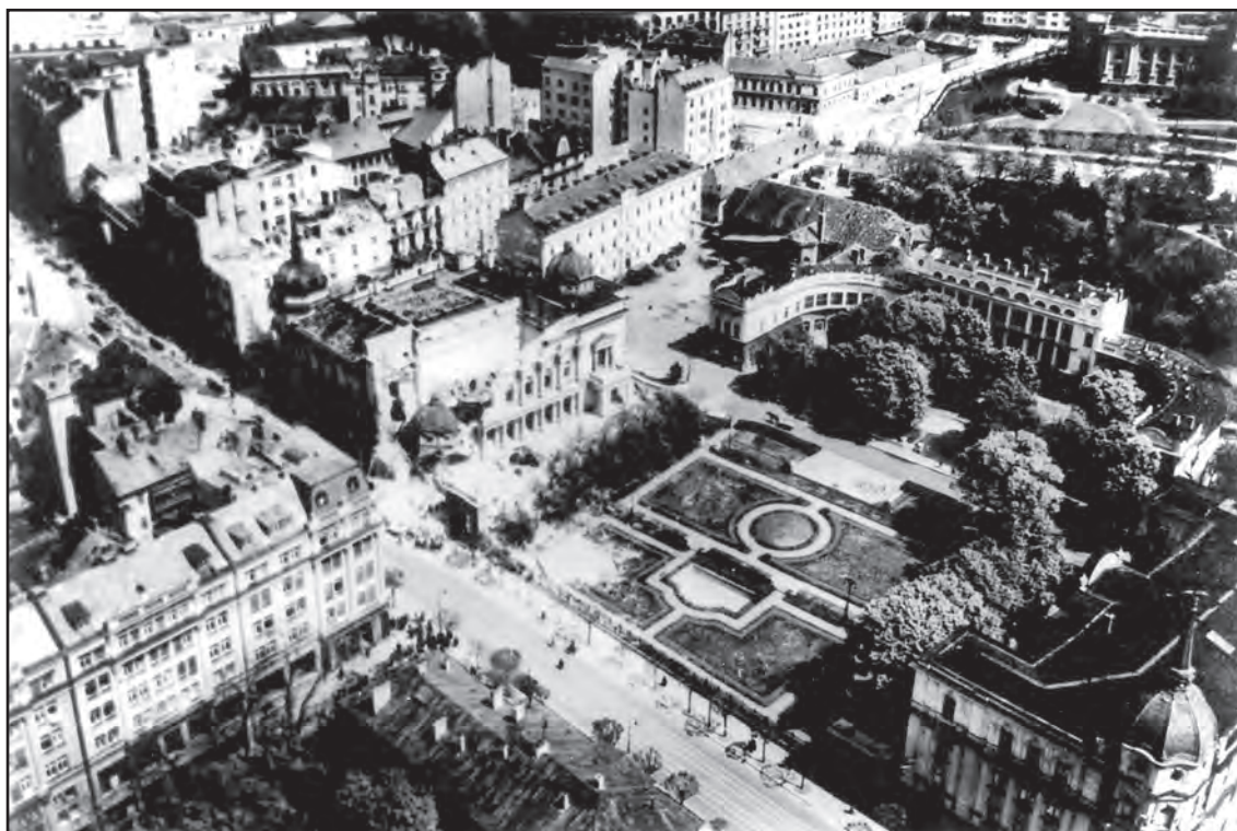
Сл. 6. Комплекс зграда Старог и Новог двора у улици Краља Милана (кат. бр. 31) Fig. 6 Old and New Palaces in King Milan Street – Cat. no 31 –
