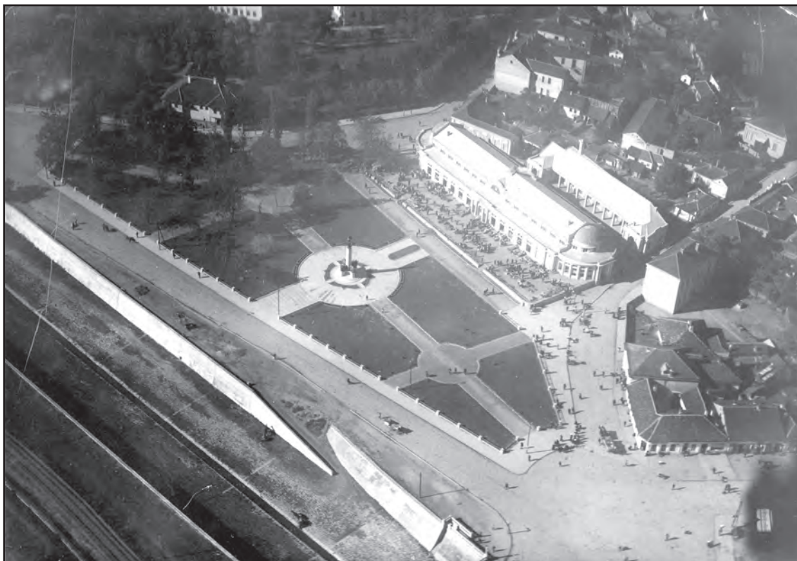
Сл. 3. Пијачна хала у Крагујевцу Fig. 3 Covered market, Kragujevac
