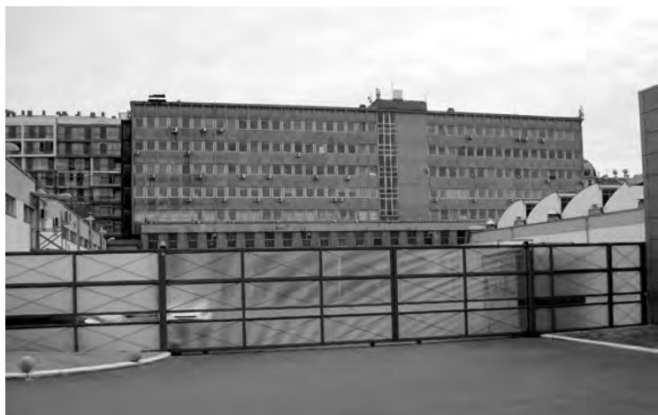
Слика 16. Управна зграда предузећа „Компресор“ Figure 16 Management quarters of the Kompesor Company
