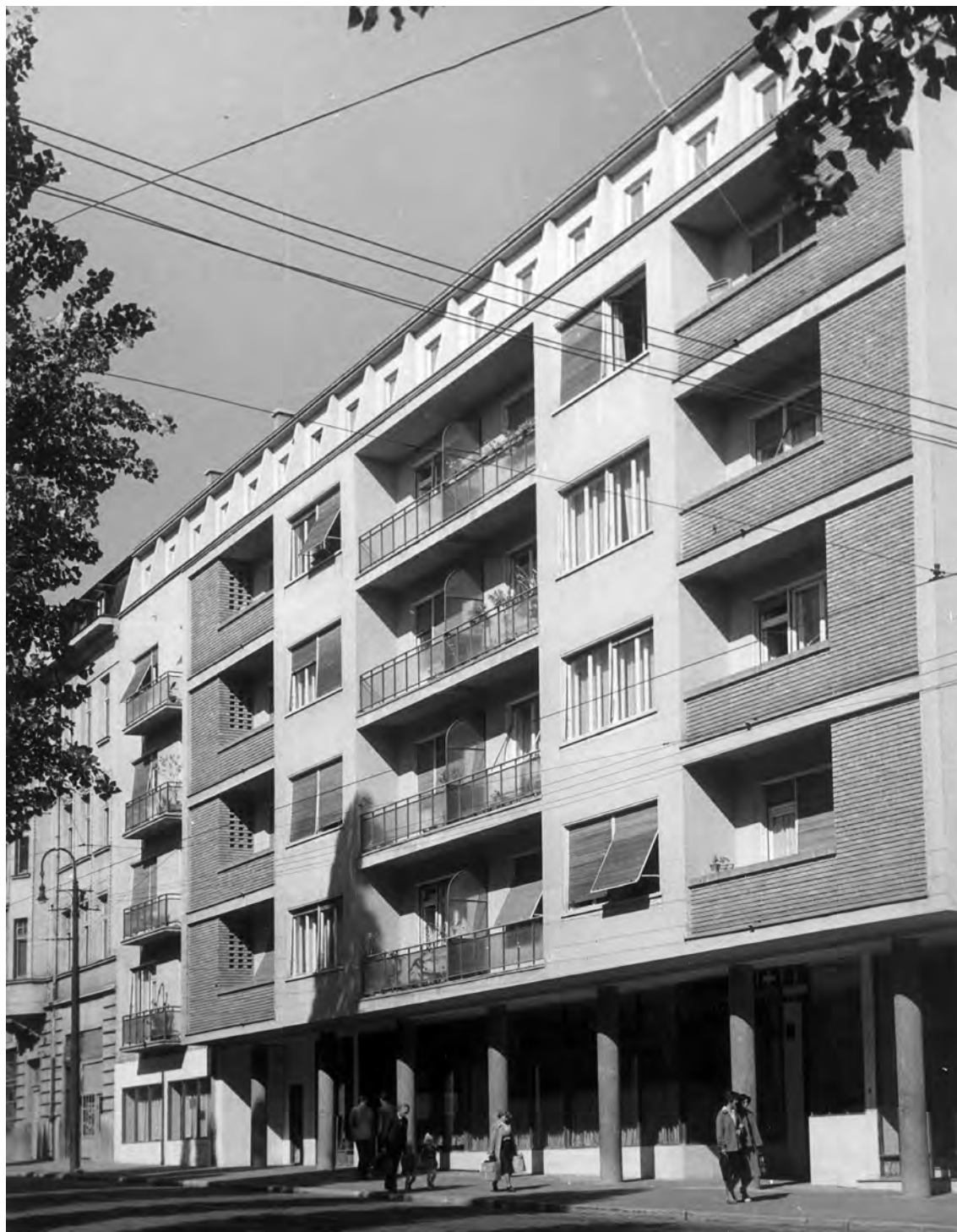
Слика 11. Стамбено-управна зграда предузећа „Јанко Лисјак“, фасада из Улице деспота Стефана (МГБ, Ур 11816) Figure 11 Residential and business building of the Janko Lisjak Company, façade facing Despota Stefana Street (BCM, Ur 11816)
