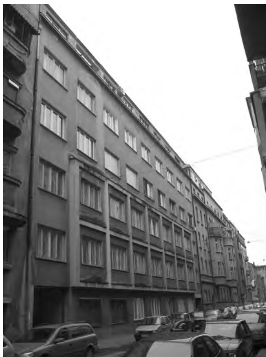
Слика 13. Стамбено-управна зграда предузећа „Јанко Лисјак“, фасада ка Дринчићевој улици Figure 13 Residential and business building of the Janko Lisjak Company, façade facing Drinčićeva Street
