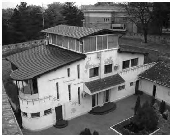
Слика 5. Зграда „Боб клуба“, главна фасада, данашње стање Figure 5 Building of the Belgrade Bobsleigh Club, main façade, present appearance
