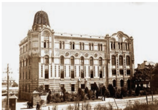
Слика 9. Арх. Бранко Таназевић, Телефонска централа, Београд Figure 9 Architect Branko Tanazević, Telephone Exchange, Belgrade
