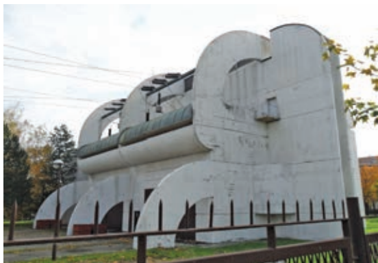
Слика 7–8. Арх. Александар Ђокић, трафо-станица Филмски град, Београд
