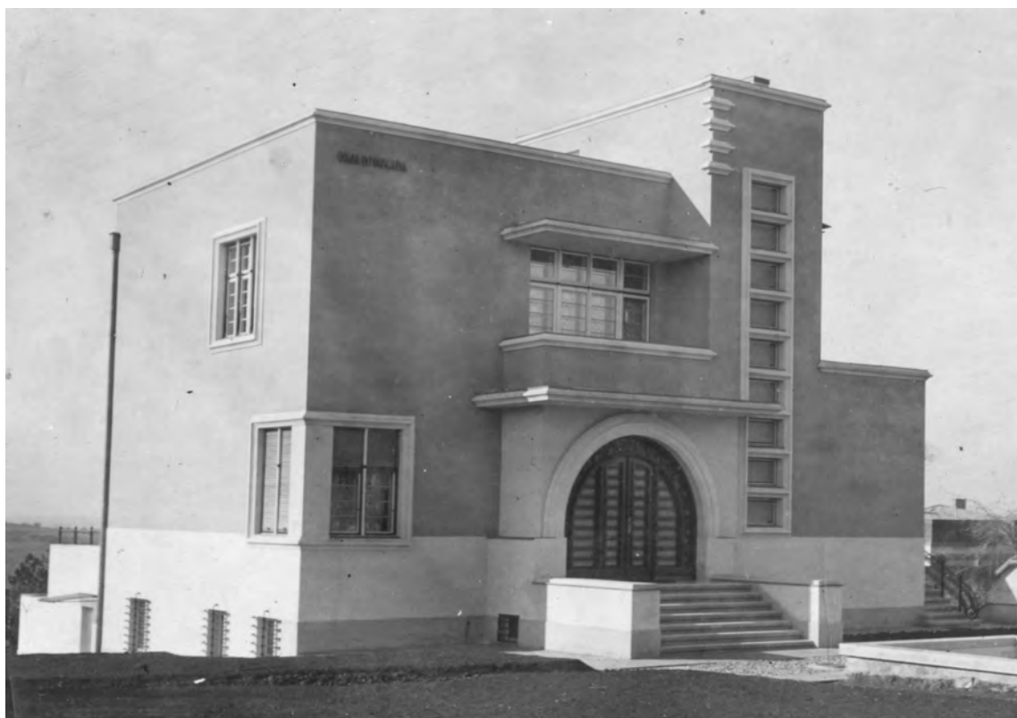
Слика 4. Вила Душана Томића по завршетку радова Figure 4 Dušan Tomić's villa after the construction was completed
